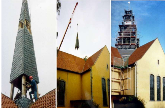
Demontage und Aufbau des neuen Turmes
