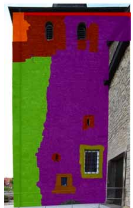
Baupläne, Bearbeitungszeit August 2010 Maßstab ca. 1:50 Dr. Ulrich Knapp, Stuttgart Str. 22, 71229 Leinberg gelb nach 1914 rot Mittelalter grün unverändert blau 1902 schwarz Schweißflächen orange 2. Hälfte 16. Jahrhundert rot 1649/50 blau 2. Hälfte 17. Jahrhundert orange 18. Jahrhundert
